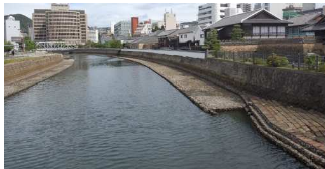
中島川変流工事と出島の護岸
